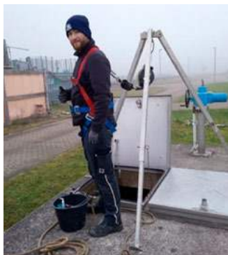
Baustellenvorbereitung für Prüfungen in Revisionsschächten – mit Personenschutztausrüstung (PSA)
