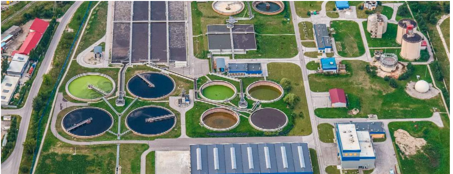
Luftbild einer kommunalen Kläranlage mit Belebungsbecken und Faultürmen (rechts)
